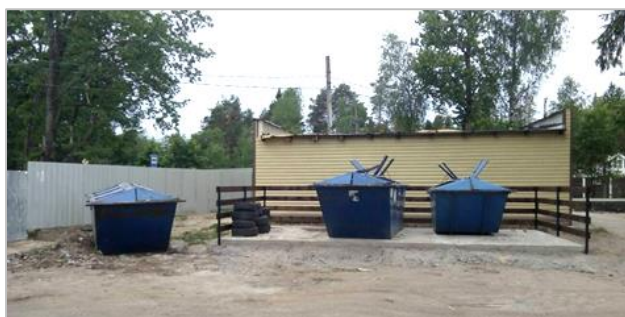
Рисунок 1.11 – Контейнерная площадка пгт. Рощино, ул. Учебная, в районе д. 7
